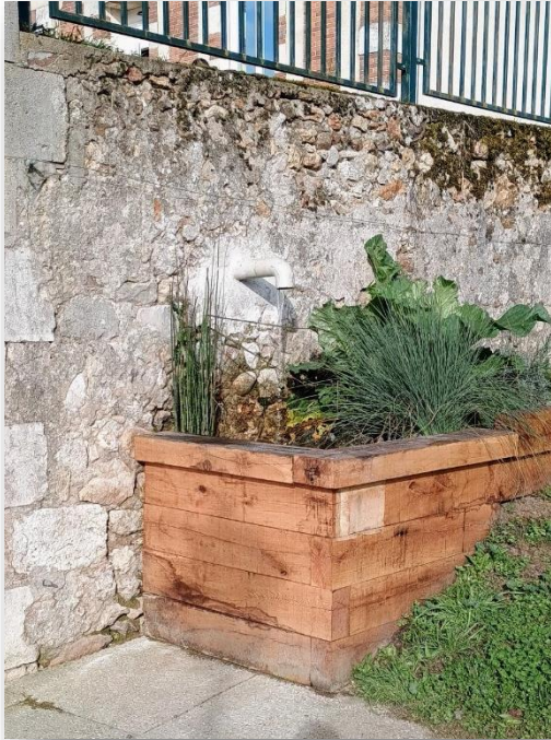
Photographie de l'installation réalisée au pied de l'école de Nevoy (Octobre 2024).
